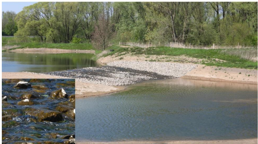
Foto 3. Ter hoogte het eindpunt van de vorige foto is een drempel aangelegd die dient als stroomversnelling (inzet)
