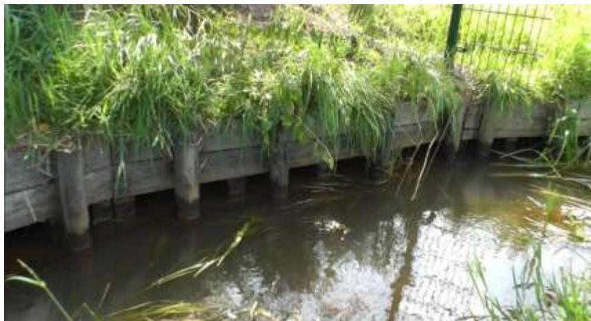
Foto 7. Kistbeschoeiing op mp. 601012.
