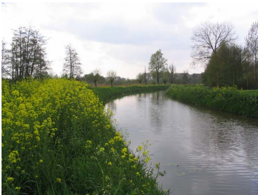
Figuur 24. Het Zuidelijk afwateringskanaal bij de duiker in de Winterdijk in zuidwestelijke richting (2-5-06)
