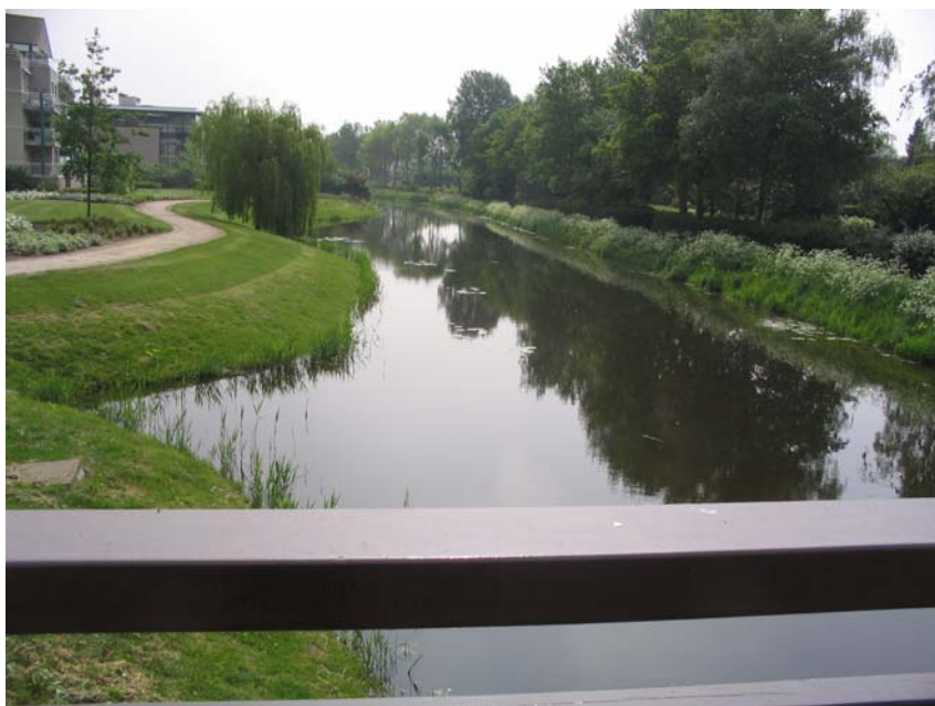
Figuur 17. Zwanengat in Zevenbergen in noordwestelijke richting (15-5-06)
