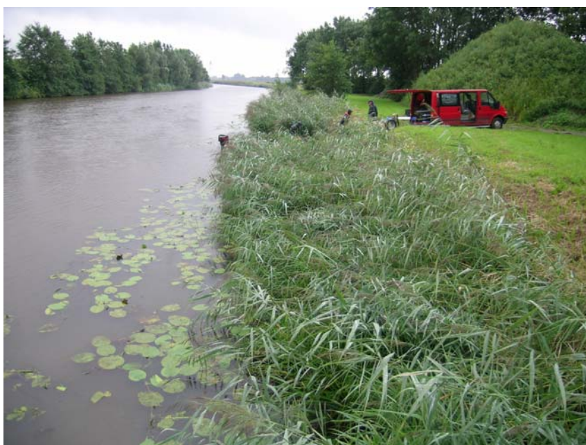
Figuur 53. Zuider Afwateringskanaal mp. 6 nabij gemaal Keizersveer in zuidelijke richting (21-8-06)
