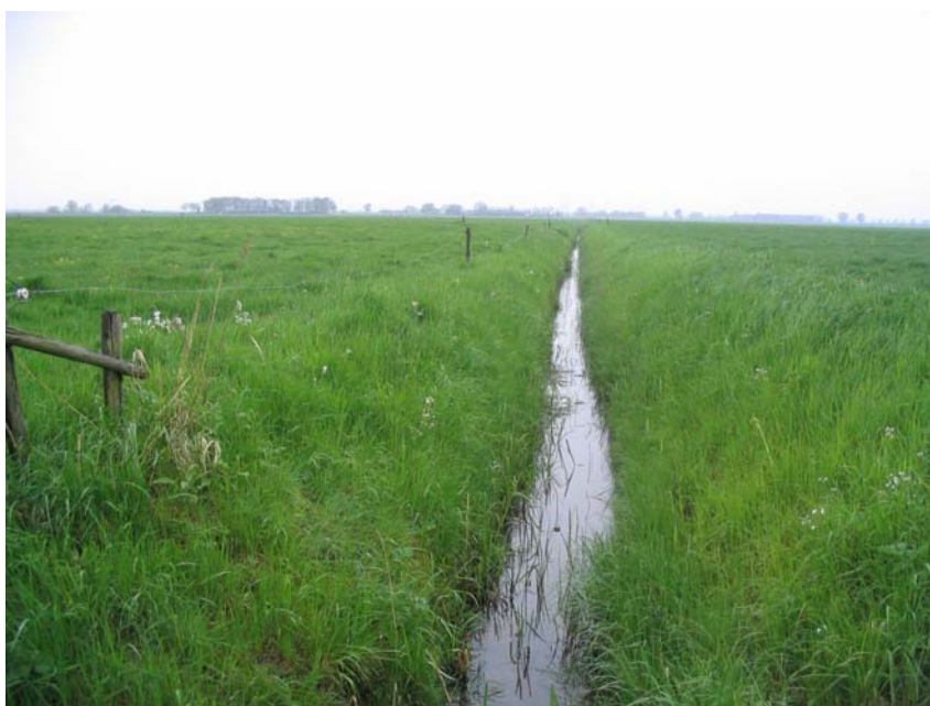
Figuur 21. Afwatering Overdiepse Polder bij duiker Graafse Weg (10-5-06)
