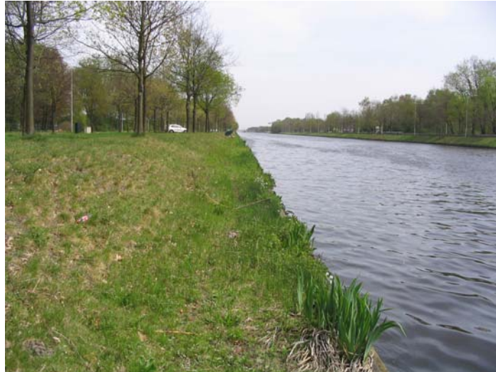
Figuur 1. Wilhelminakanaal in oostelijke richting (4-5-06)
