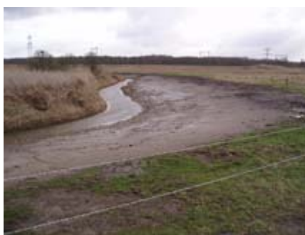
Figuur 65. Blaffert, project in uitvoering
