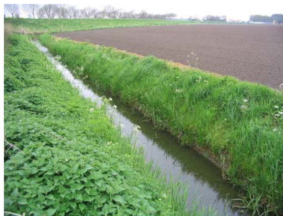
Figuur 13. Afwatering Oude Appelaar bij Stampersgat in westelijke richting (29-4-05)
