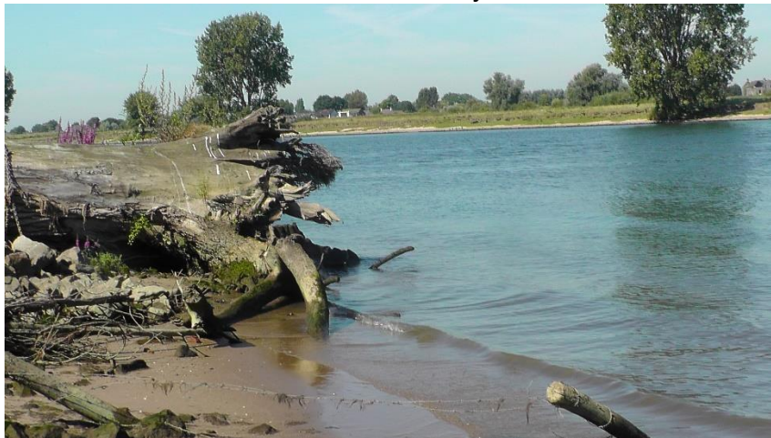
Km. 214.600 linkeroever Gewande zomer 2016
