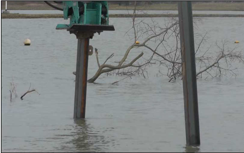
Figuur 4. Intrillen van verankeringsbalken in de strang bij Everdingen
