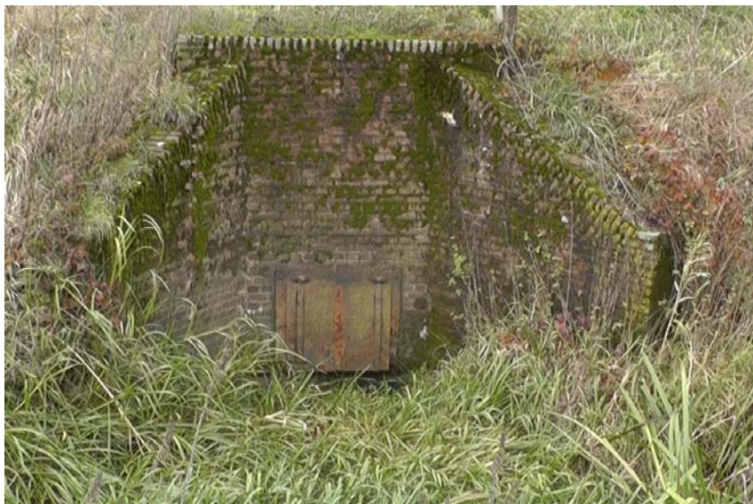
Foto 8. Oude duiker met terugslag klep om rivierwater buiten te houden
