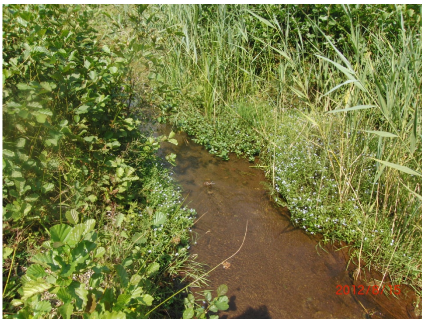
Foto 8. 201020, nieuw aangelegde benedenloop met flauw talud en zandgrindbodem (benedenloop).
